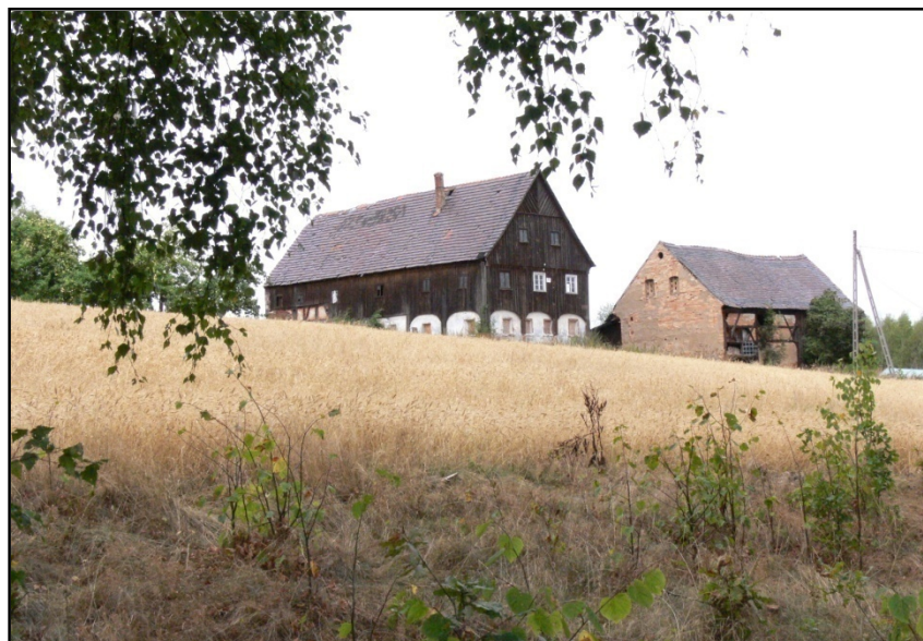
Fot. Zabytkowa zabudowa szachulcowa.
