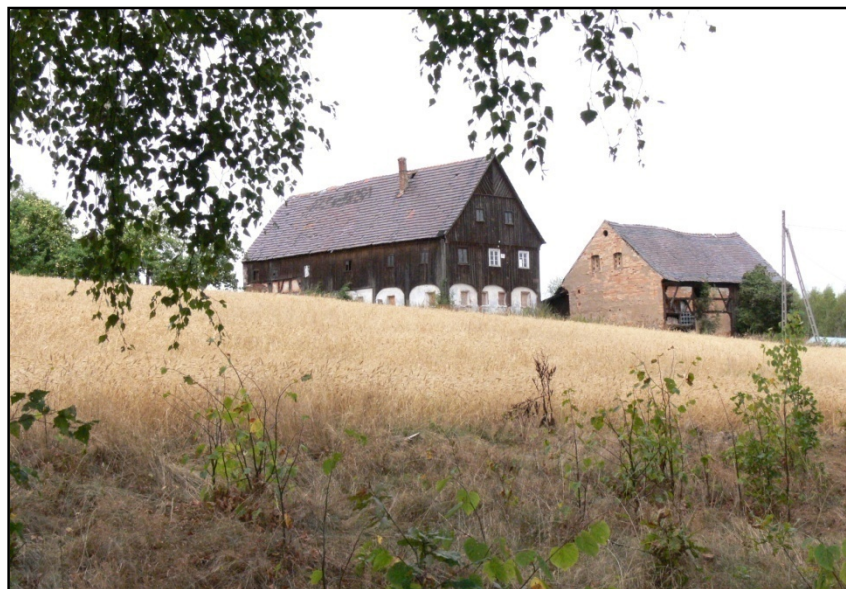
Fot. Zabytkowa zabudowa szachulcowa.
