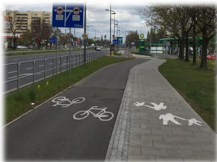
Foto. nr 2. Droga dla pieszych i droga dla rowerów (separacja kostką granitową + różnica wysokości), oznakowanie poziome: P-23 „rower”, P-26 „piesi”.
