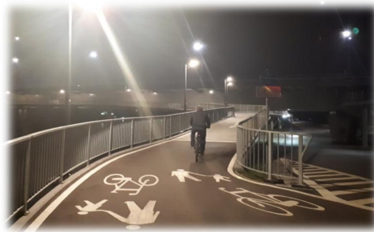
Foto. nr 9. Oświetlenie kładki pieszo-rowerowej.
