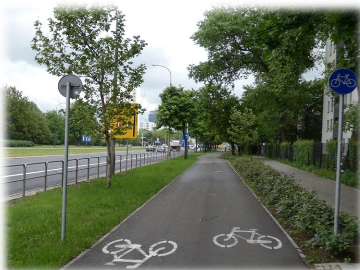
Foto. 1. Wydzielona droga dla rowerów – dwukierunkowa z separacją zieleńcem (szerokość 2,5 m, nawierzchnia asfaltowa, oznakowanie pionowe C-13, oznakowanie poziome P-23).
